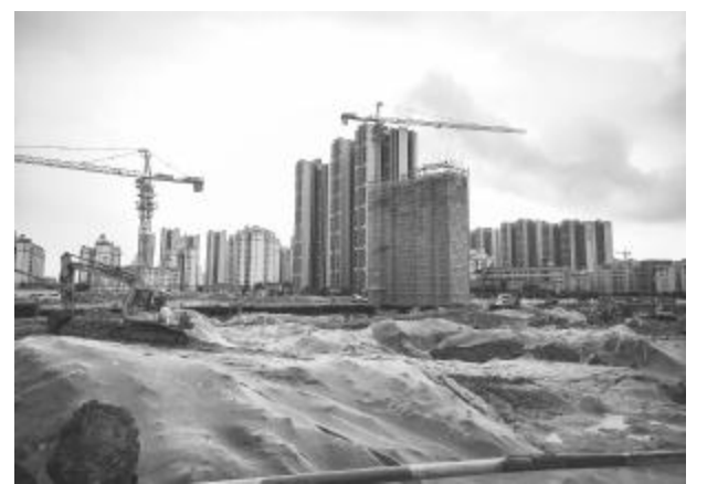
时代倾城第5期工地裸土已覆盖防尘网。
